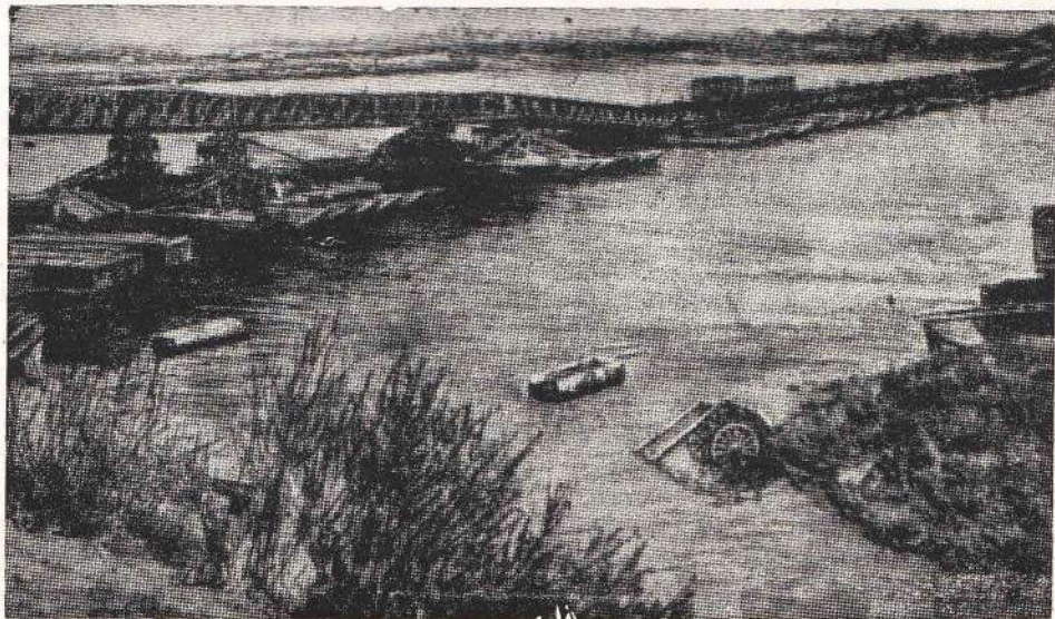
Сл. 5 — 40-тонски мост „Бејли“ на пловним потпорама подигнут на Рајни код Везела
