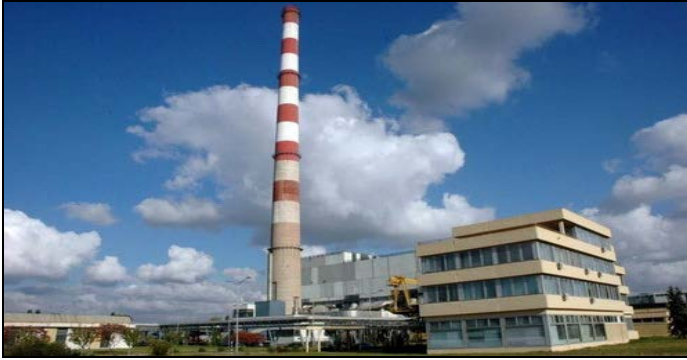
Слика 3 – Термоенергетско постројење
