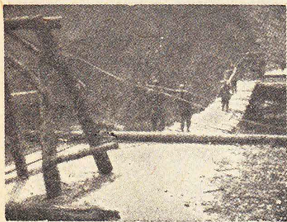
Sl. 3 — Novi pešački most koji su Kinezi podigli uz potporne stubove starog mosta
