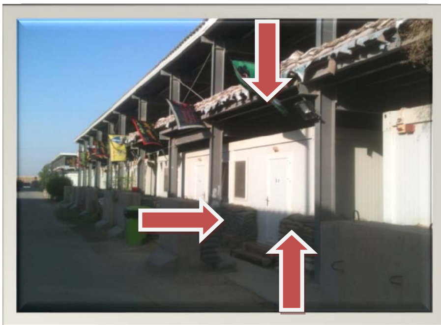
Армирано-бетонски елементи и вреће са песком, као заштита од парчадног дејства минобацачких мина
