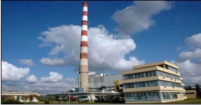
Слика 3 – Термоенергетско постројење
