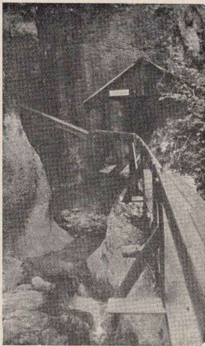
Sl. 20 — Hidrocentrala SKVPB »Franja«
