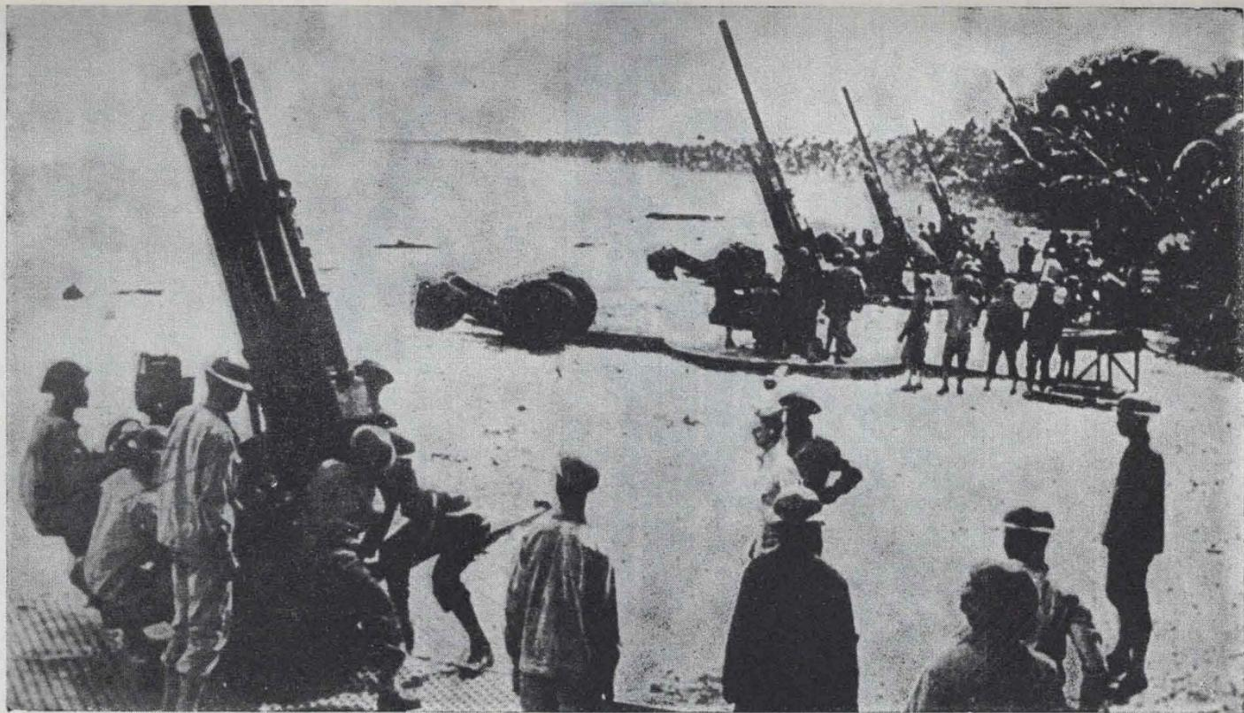
Baterija 90 mm PA topova u dejstvu. U toku rata, ove baterije su dobile radiolokatore i ostvarile automatski prenos elemenata na oruđa
